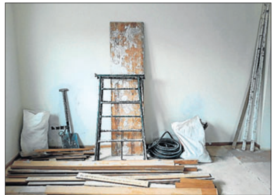
Reformar alarga la vida útil de la vivienda y mejora su habitabilidad.
